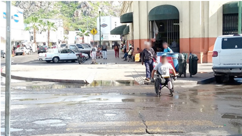
Fotografía del autor (2017). Se observa una rampa para discapacitados encharcada.
