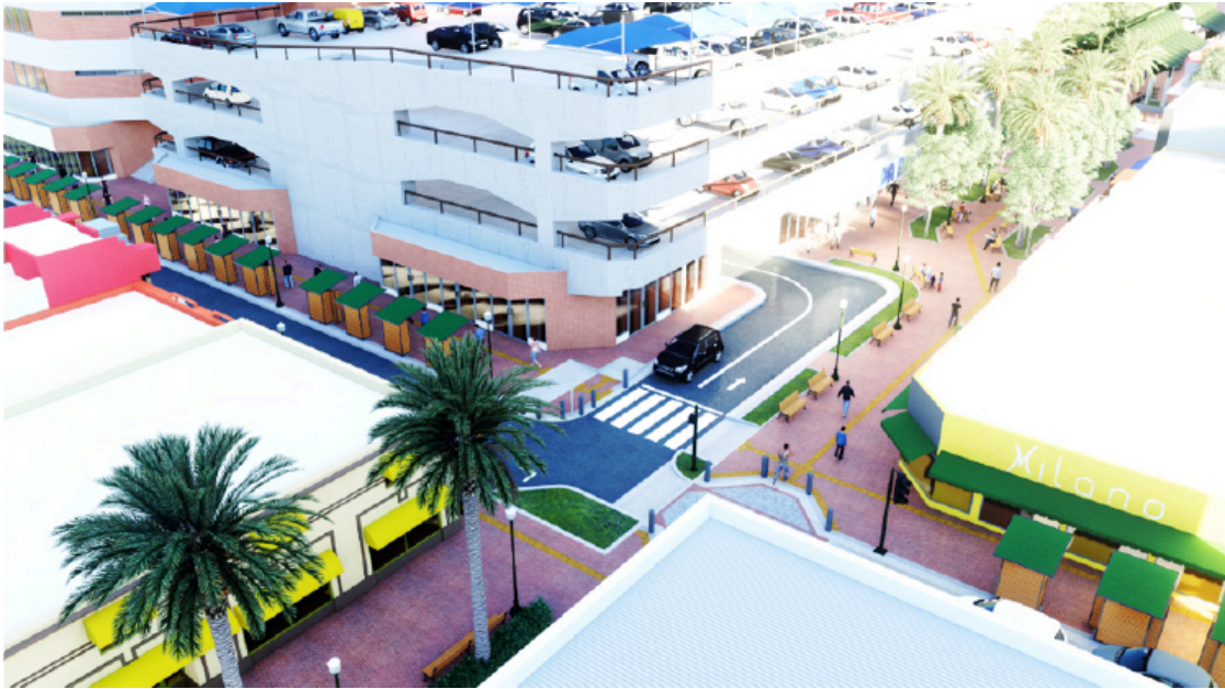
Figura 6.5 Acceso al estacionamiento del edificio El Paríán
