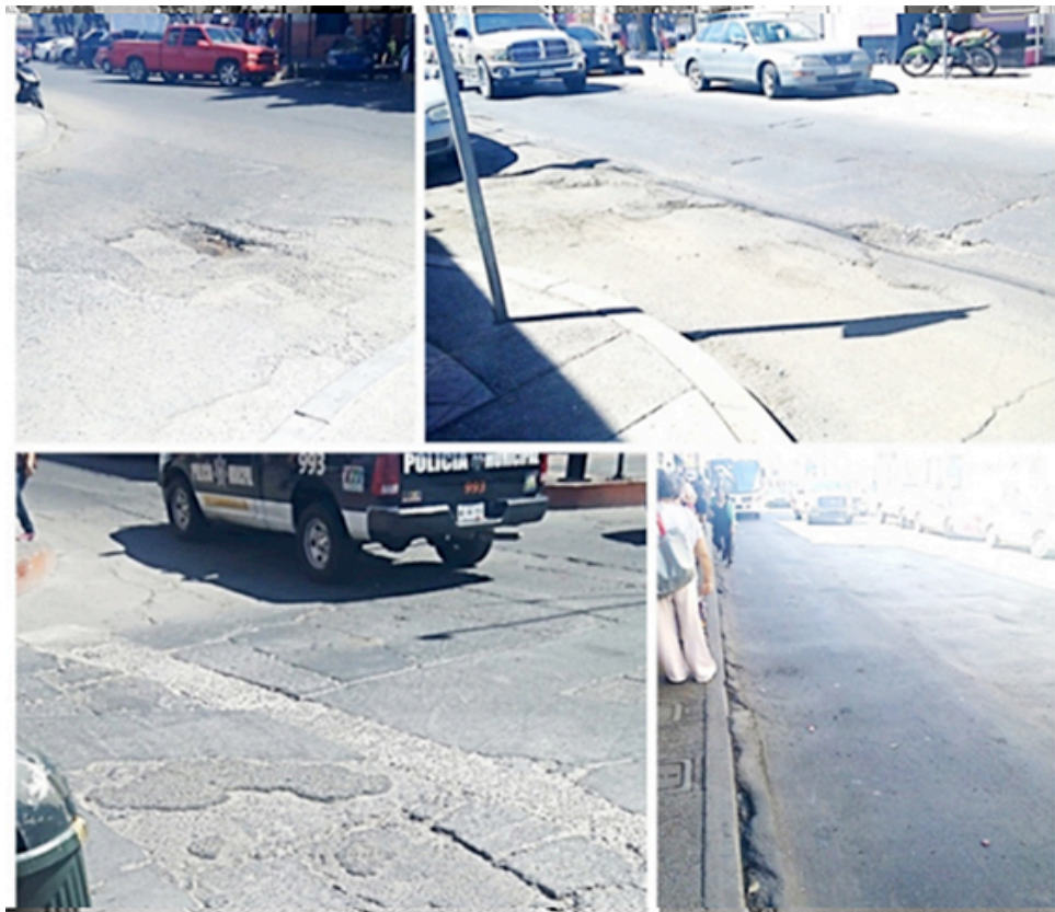
Fotografías del autor (2017). Se observa el daño en las vialidades causado por el medio motorizado y la mala calidad de la construcción.
