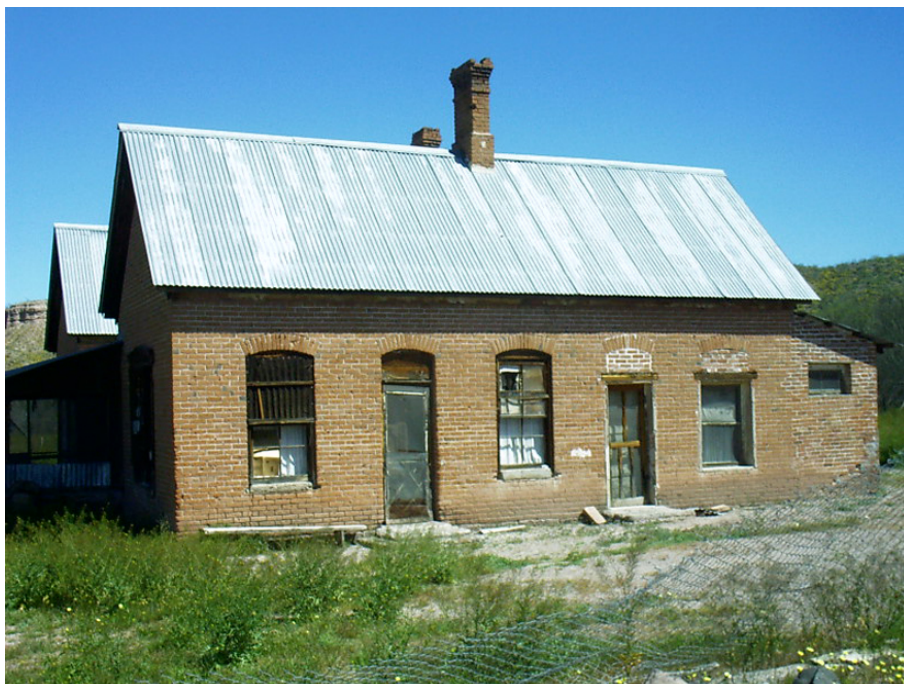
Figura 35. Vivienda de Colonia Oaxaca que perteneció a James Harvey Langford y que se construyó en 1895
